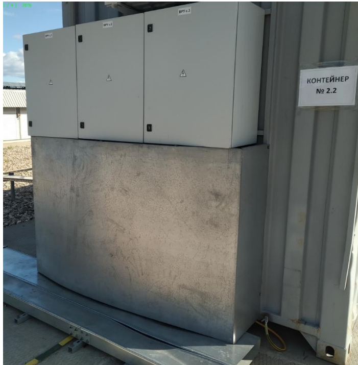
Рисунок 1. Вариант установки шкафов ВРУ
